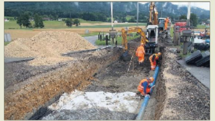
Installation de la nappe synthétique et du drainage.
