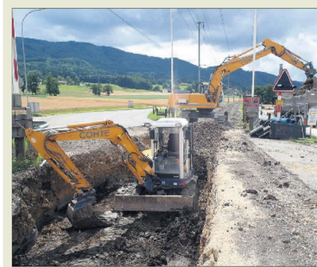
La voie a été creusée en profondeur afin de recréer une infrastructure optimale.
