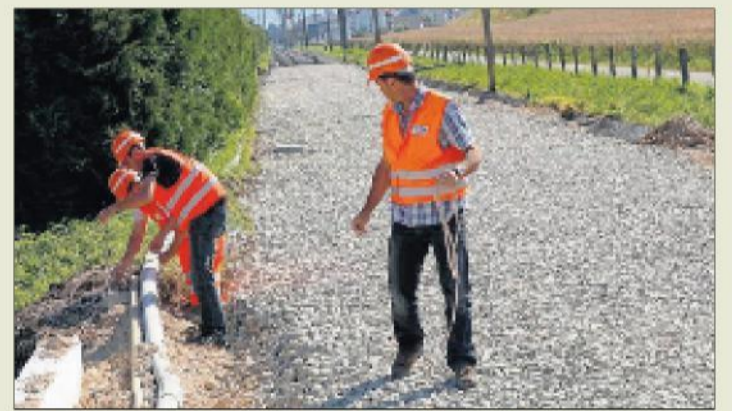
Le ballast est en place et peut accueillir les nouveaux rails.
